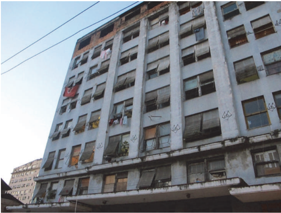
Parte de trás do prédio da Zumbi dos Palmares
