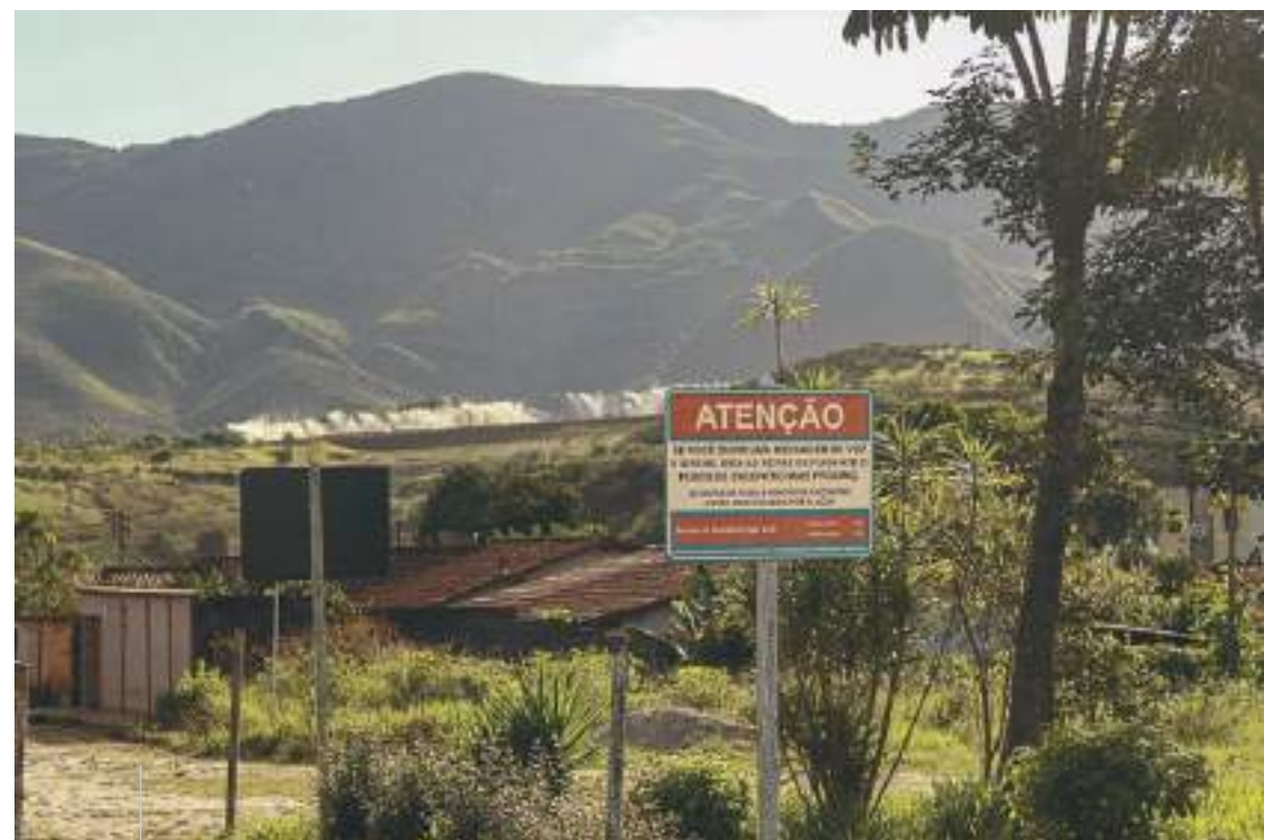
Ao centro da foto, a Barragem Doutor. A placa contém instruções a serem seguidas pela população em caso de rompimento.
