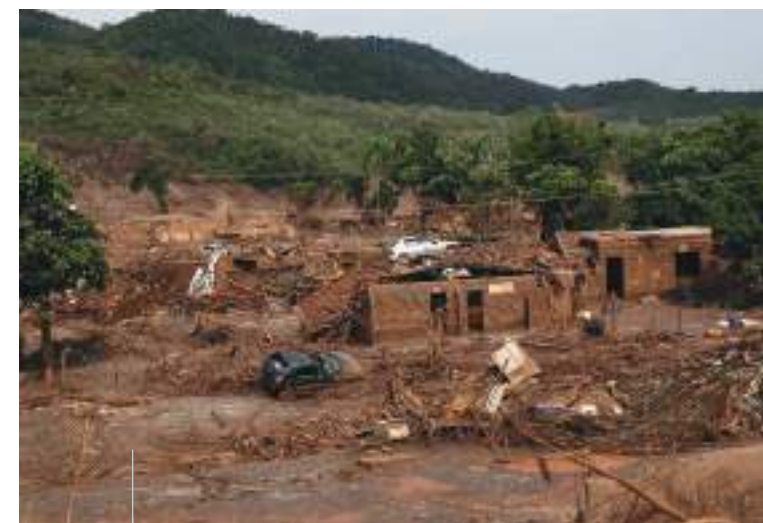
Casas e carros destruídos pelo rompimento da barragem em Mariana
