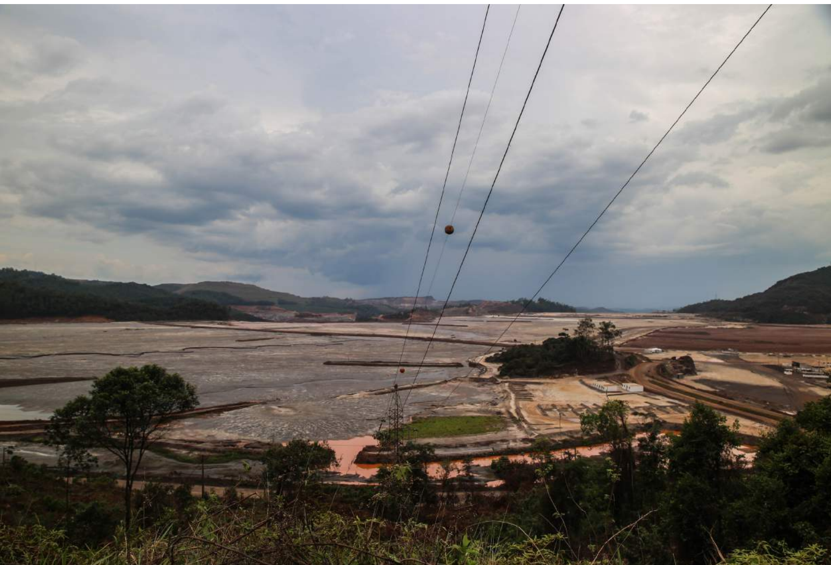
Barragem de rejeitos de Germano
